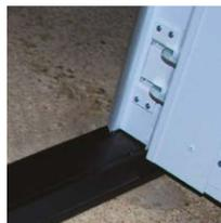
Une faible hauteur de seuil de 25 mm et une largeur de 800 mm permettent un passage aisé.
